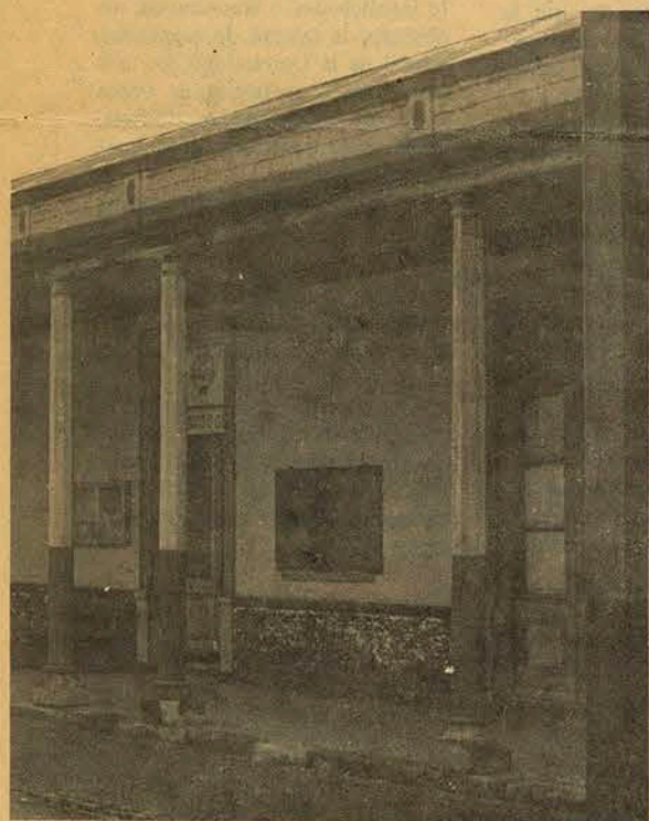
Edificaciones como la del grabado, de la Escuela de Construcción Civil de Santiago, datan del siglo pasado.
